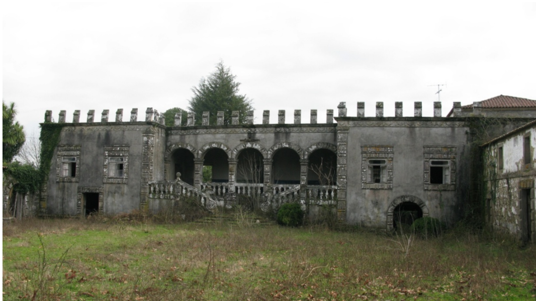
Fig. 1 - Fachada atual do solar
