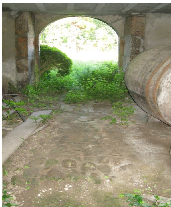
Fig. 6 Acesso ao pátio interior
