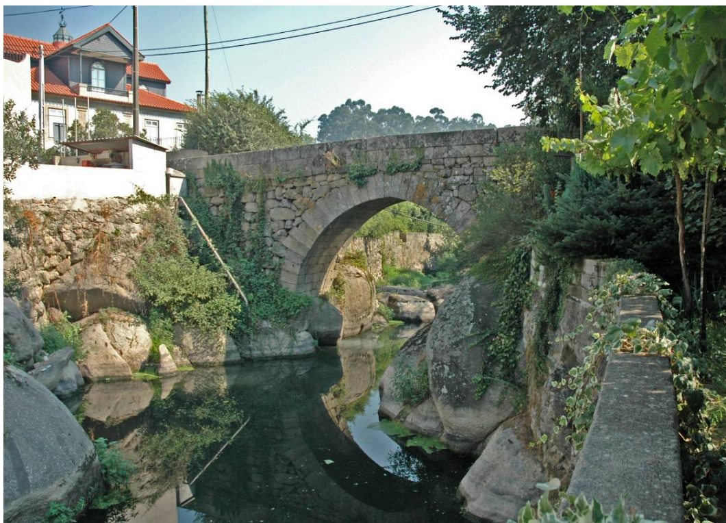
Fig. 2 Ponte de Cepeda sobre o rio Sousa
