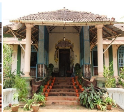
Fig. 5 - Alpendre da Casa Gracias em Loutolim | tipologia: Casa Pátio
