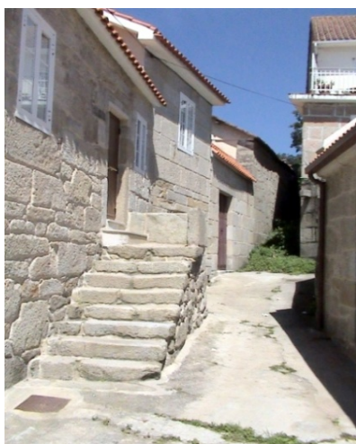
Ilustración 5 Casa con patín paralelo a la fachada y adosado a ella (Foto: A. Mesía, agosto 2008)
