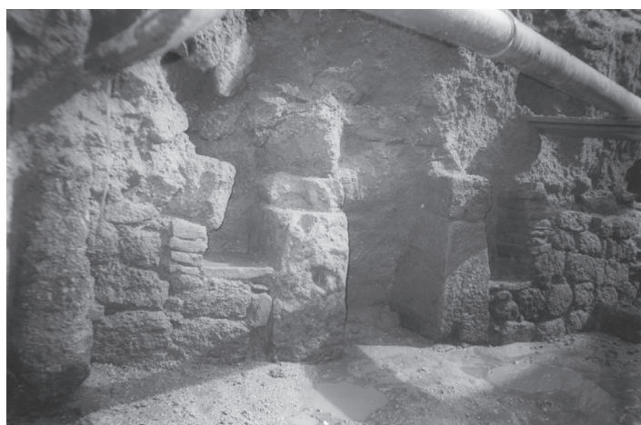
Fig. 18 – Idem. Estrutura adjacente à entrada do praefurnium , sugerindo um outro tanque.
