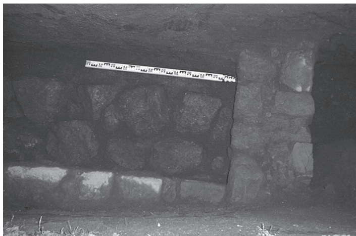
Fig. 16 – Idem. Pormenor do cunhal de um muro, o qual se sobrepõe ao alicerce de um outro, mais antigo.
