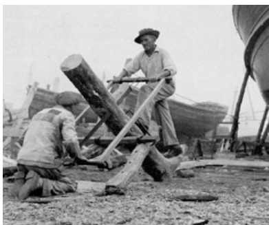
Fig. 1: Corte e tratamento da madeira.
