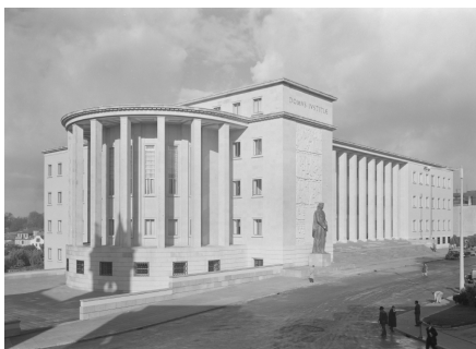
Fig. 8 - Fachada Principal. Estúdio Mário Novais. FCG
