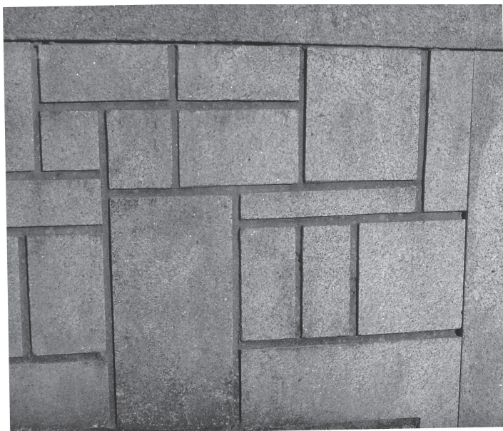
Fig. 7- Fotografia de parede
