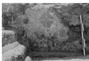
7. Parede tanque - CS93 (foto MADDS)
