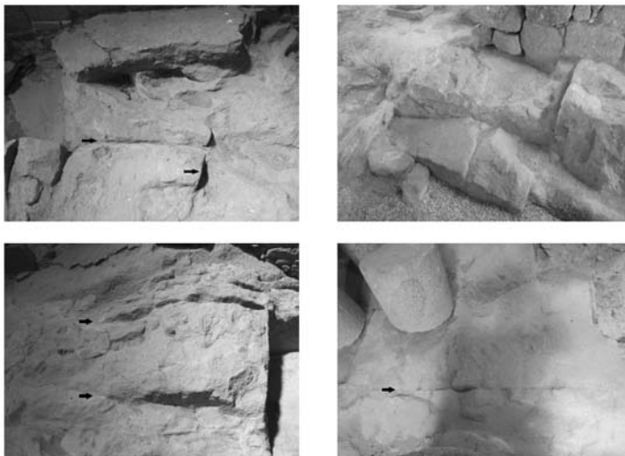
Figura 13: Identificação de diáclases no substrato rochoso das termas
