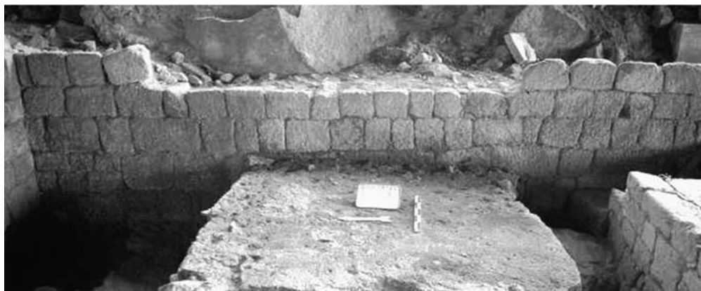
Figura 26: Muro 1 – Ed.PT (foto MRADDS)
