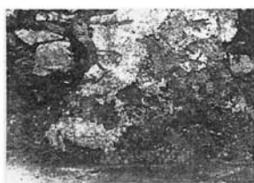
6. Parede tanque - CS68 (foto MADDS)
