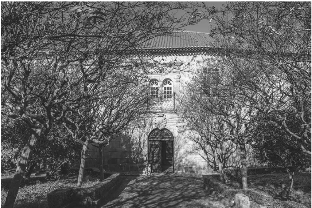
Figura 50 – Casa do Miradouro.
