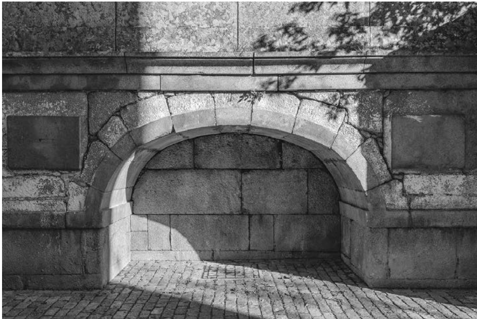
Figura 47 – Vestígios da Fonte do Arco.
