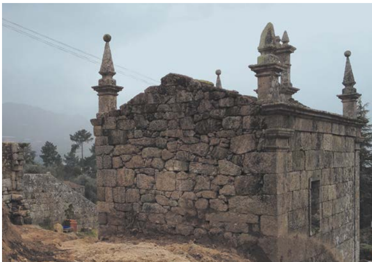
Figura 4. Ruína da Casa de Covela. Fachadas tardoz e lateral Noroeste.
