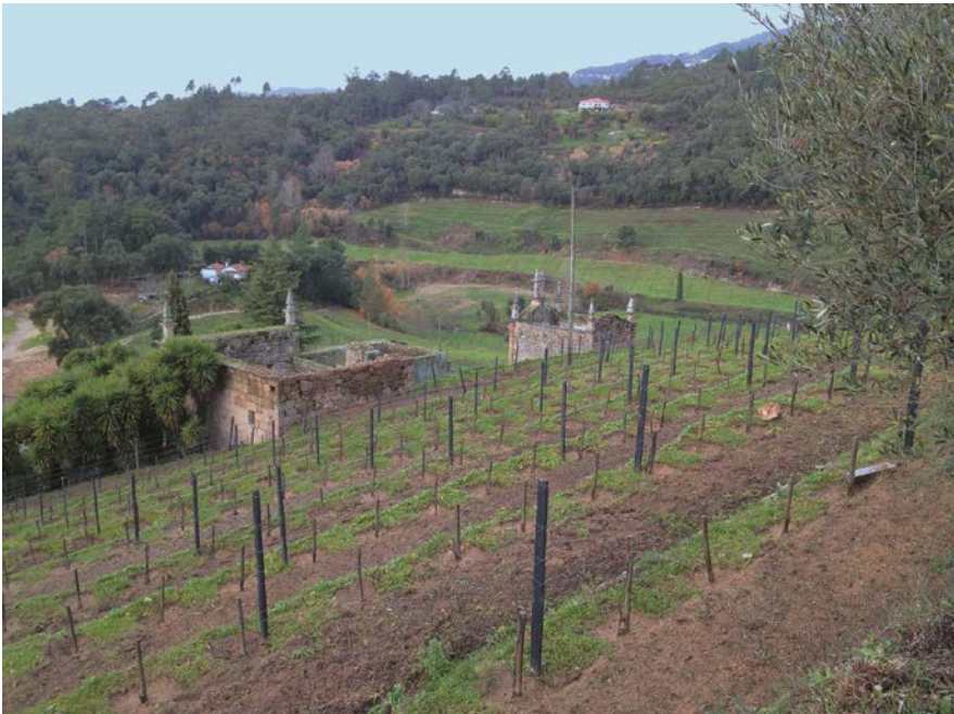
Figura 3. Ruína da Casa de Covela. Fachadas tardoz e lateral Sudeste.
