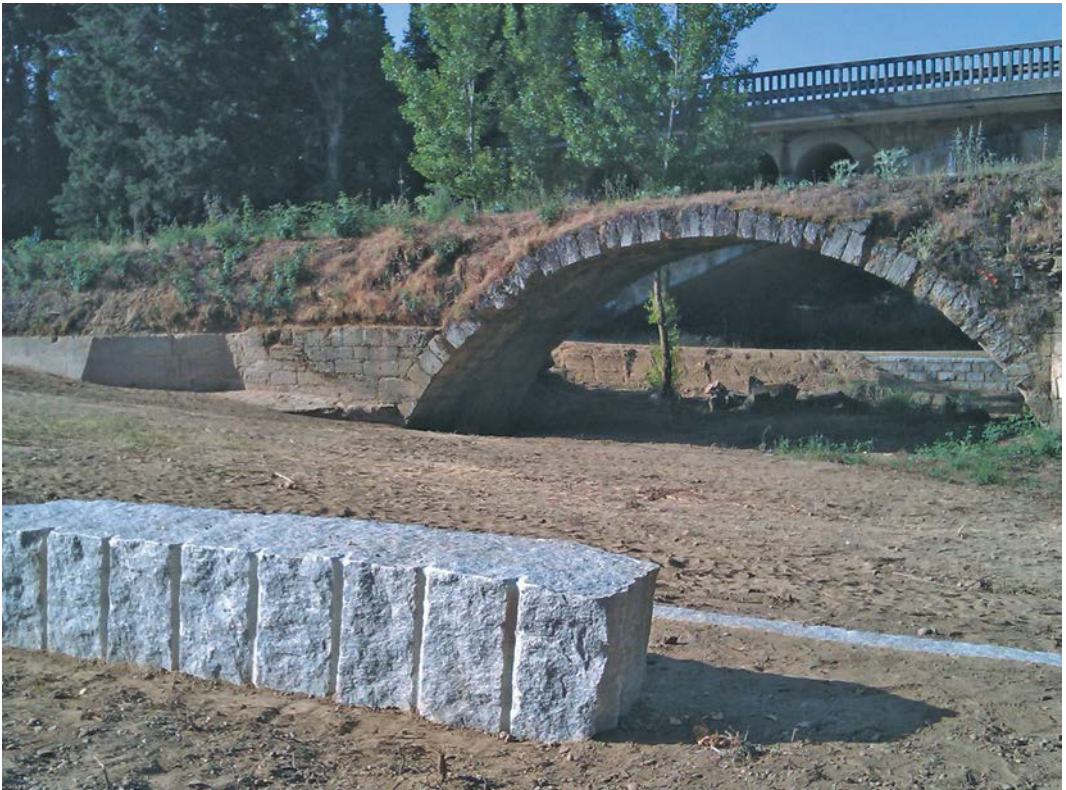
Figura 9. Iter Plata. Aula al aire libre de los puentes de Castrogonzalo, Zamora. Detalle de la intervención.
