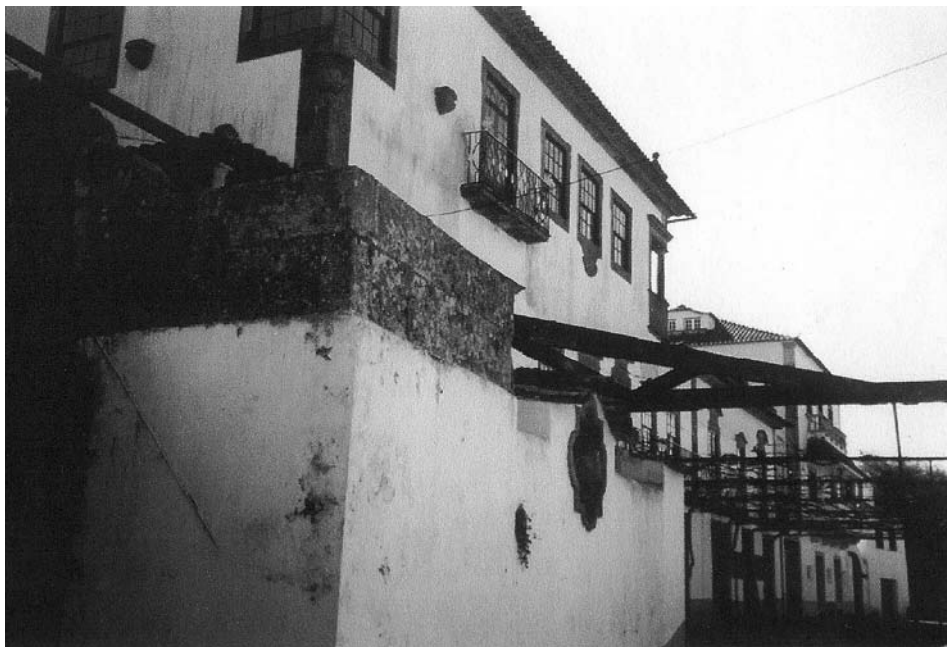
I e II- As casas de João Cosme do Caes Seixas, avô de J.A. Costa Fotografias actuais do conjunto edificado, denunciando sucessivas ampliações. Trata-se de um dos mais imponentes edifícios de Seixas, evidencia, quer pela localização privilegiada ( cais de S. Sebastião ) quer pela consistência formal, o estatuto social do seu proprietár
