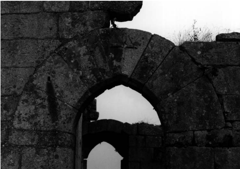
Fig. 6 - Estrutura anexa à Torre de Manhente. Porta da parede Oeste, criada no Séc. XIV e reaproveitando aduelas de arco pré-românico.
