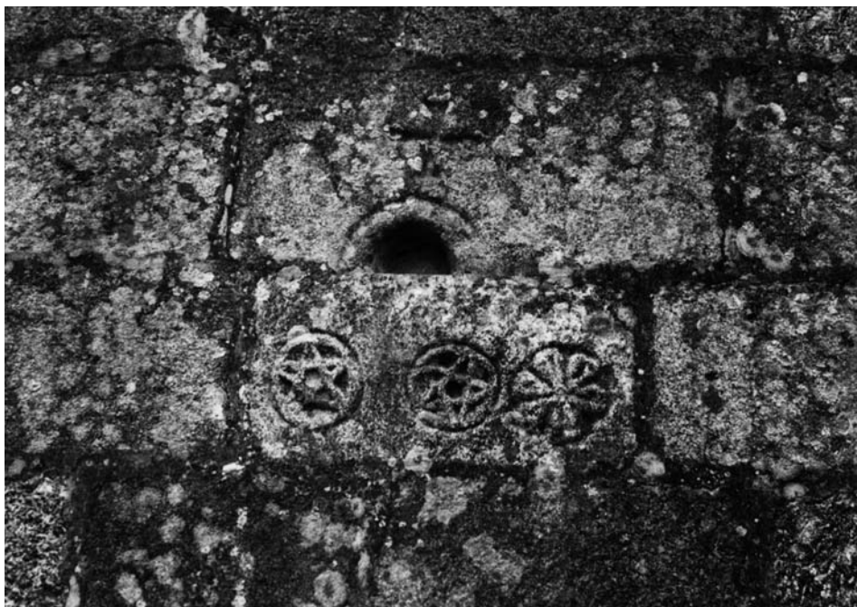
Fig. 1 - Pedras altimedievicas reaproveitadas na parede Leste da capela-mor de Manhente.
