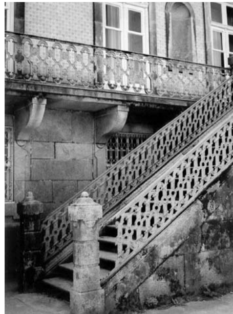
Fig. 18 – Casa do Campo Pequeno, detalhe das grades do alçado posterior
