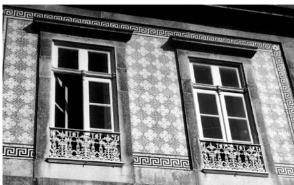
Fig. 13 – Casa do Campo Pequeno, detalhe da fachada principal
