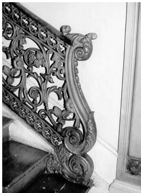
Fig. 20 – Casa do Campo Pequeno, arranque da escadaria nobre (detalhe)
