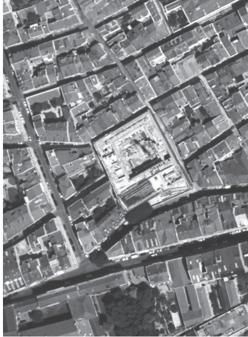
Fig. 7 - Mosteiro de N. Sr a de Nazaré do Mocambo (“Convento das Bernardas”) durante as obras de reabilitação. Podem observar-se os limites e inserção do Mosteiro na actual malha urbana de Lisboa (foto: IgeoE)
