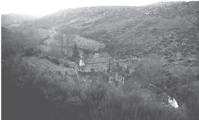
Fig. 6 - Mosteiro de St a M a das Júnias (foto: AMM)
