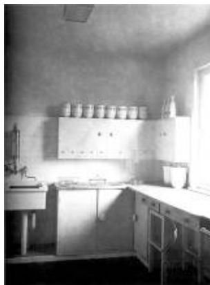
Fig.4 - Imagem da cozinha da Casa “Am Horn”, 1923. (DROSTE, 1994,p.108) Esta é a primeira cozinha que alia a preparação dos alimentos e o seu armazenamento, através da utilização de armários fixos localizados por debaixo da banca de trabalho e em cima encastrados na parede. É uma cozinha concebida unicamente como local de trabalho, com uma disposição em L, com uma grande bancada de trabalho contínua, nivelada sob um vão de janela. A eficácia do funcionamento da cozinha é notável.
