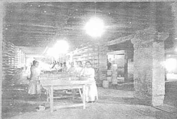
2.º PAVIMENTO DOS FORNOS
