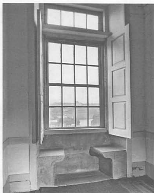
Fig. 2. Janela conversadeira, Colégio de S. Lourenço do Porto
