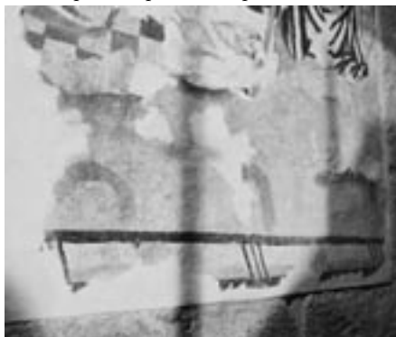
Fig. 8 – Pormenor da composição Natividade onde se pode observar a existência de uma área lisa de cor rosa e uma barra de enrolamento pintados num fragmento de reboco que corresponde a outra pintura anterior.
