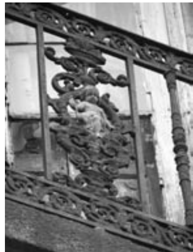
Fig. 17 - Casa de José de Almeida Cardoso: detalhe de uma grade do piso nobre com motivos renasença em metal fundido
