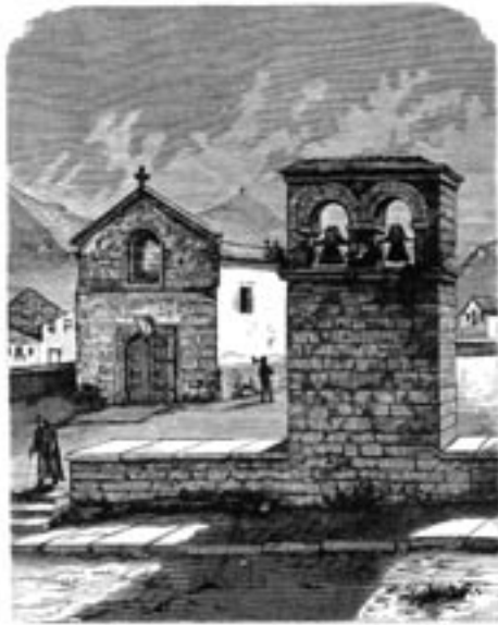
Fig. 3 - A igreja de S. Bartolomeu antes da demolição.
