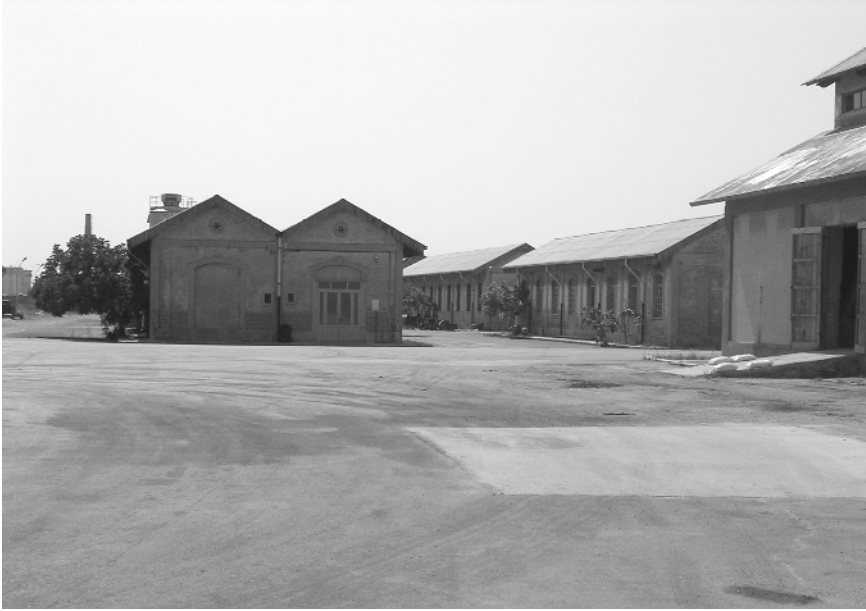
Fig. 11 Padiglioni per accoglienza operai.
