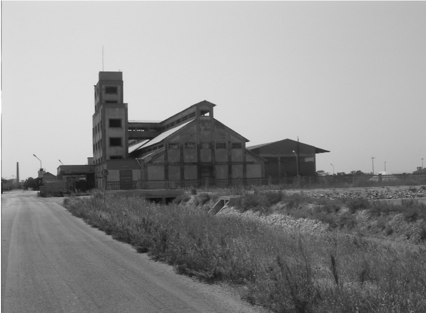
Fig. 12 Edificio per ammassamento e "sofisticazione" sali.
