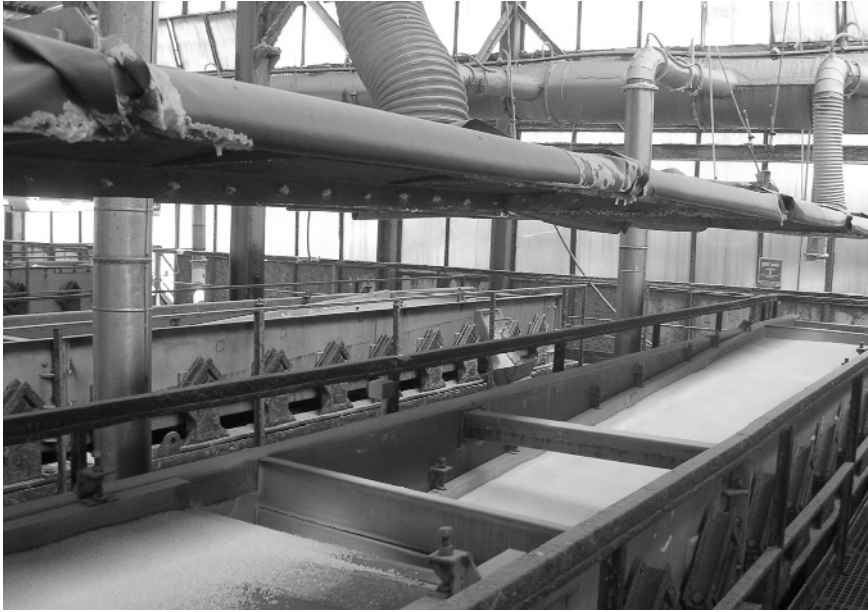
Fig. 7 Area impacchettamento, vibrovagli lineari.
