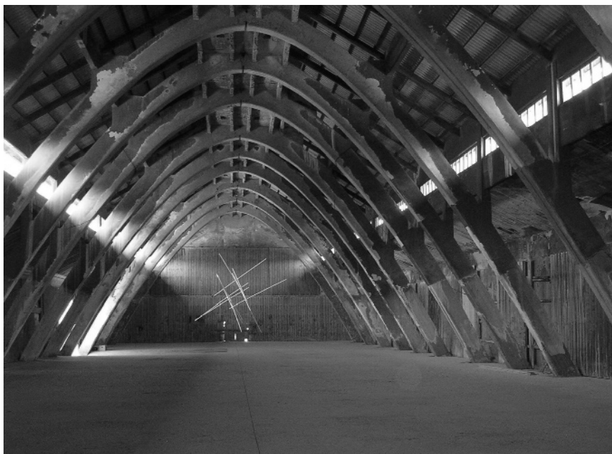
Fig. 13 Padiglione "Nervi" nell'edificio per ammassamento e sofisticazione sali.
