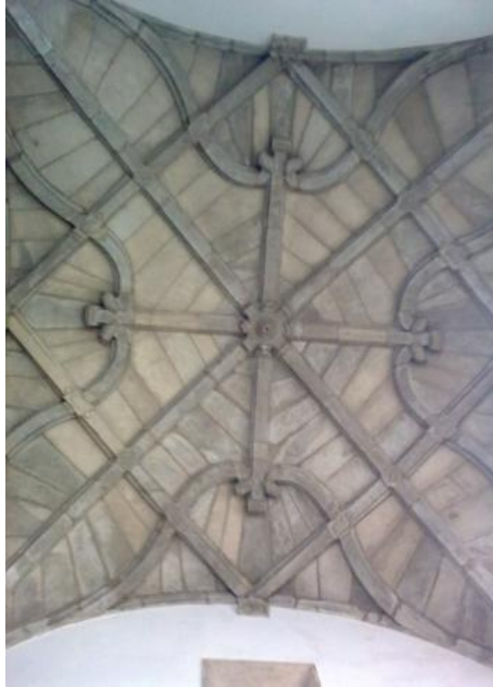
Figura 4 – Capela dos Alfaiates, vendo-se a abóbada de nervuras.
