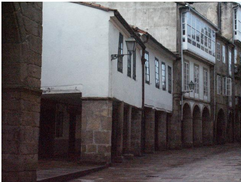
Lám. 7. Solución de viviendas caleadas en la Rúa Nova
