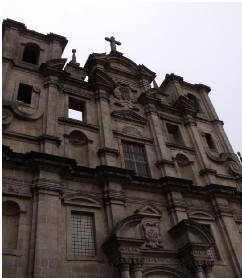
Figura 15 – Igreja de São Lourenço, fachada.
