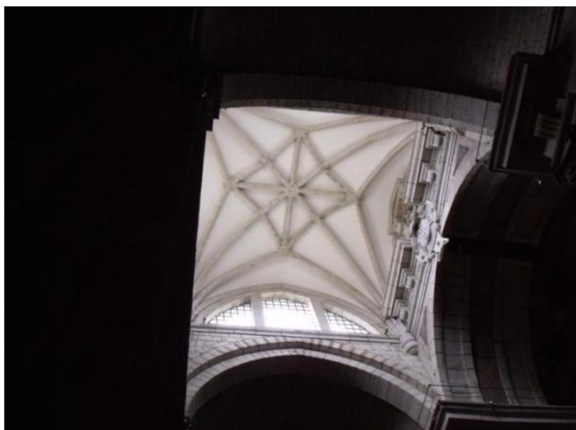
Figura 21 – Sé do Porto, lanternim.
