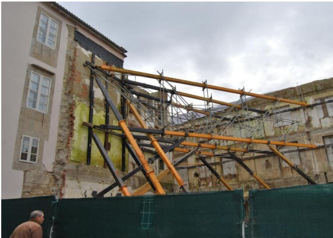
Lám. 17. Solar en construcción del antiguo Banco de España. Plaza de Platerías
