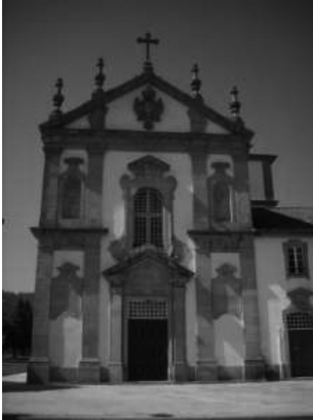
Figura 2 – Fachada da igreja (lado sul).
