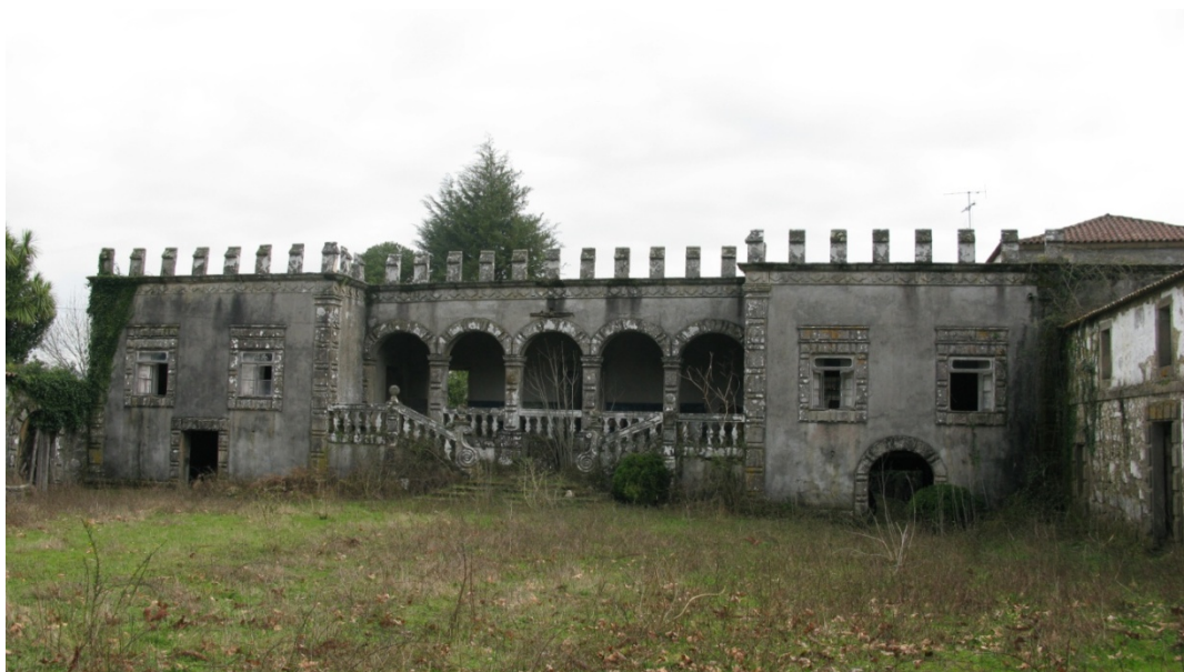
Fig. 1 - Fachada atual do solar
