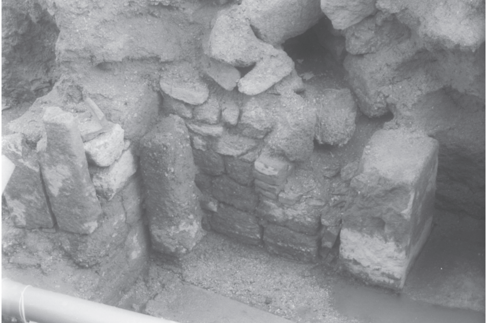
Fig. 19 – Idem. Vista geral do tanque notando-se o estado de degradação avançado, fruto de sucessivos rearranjos das captações de água termal, um dos quais é visível ao centro.
