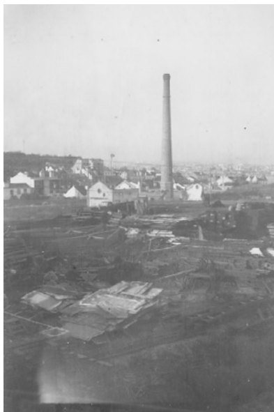
Foto nº1: Desmantelar da Fábrica Buckhnal em 1952, de Alexandrino Pinheiro
