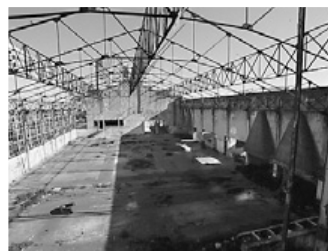
Fig. 10 – AEL, interior da secção de fabrico, vista sobrelevada a partir da açoteia (fotografia do autor, 1999).
