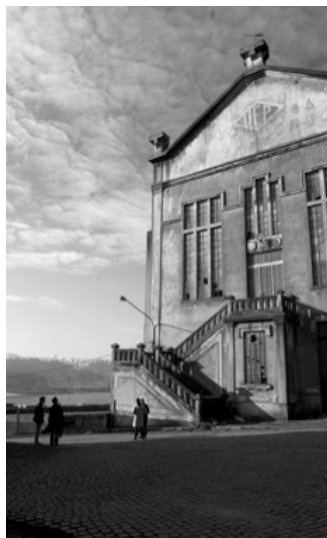
Fig. 7. Fachada principal da Central Termoelectrica do Freixo (ano de 2006)
