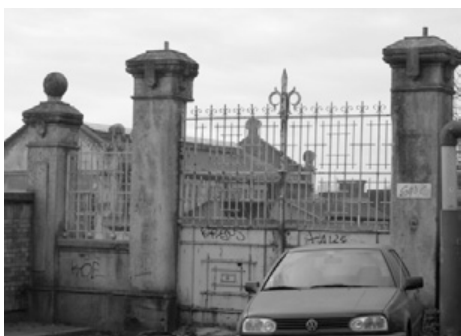
Fig.9. Portão de Entrada para a Central Termoelétrica – rua do freixo – Campanhã (ano 2011).
