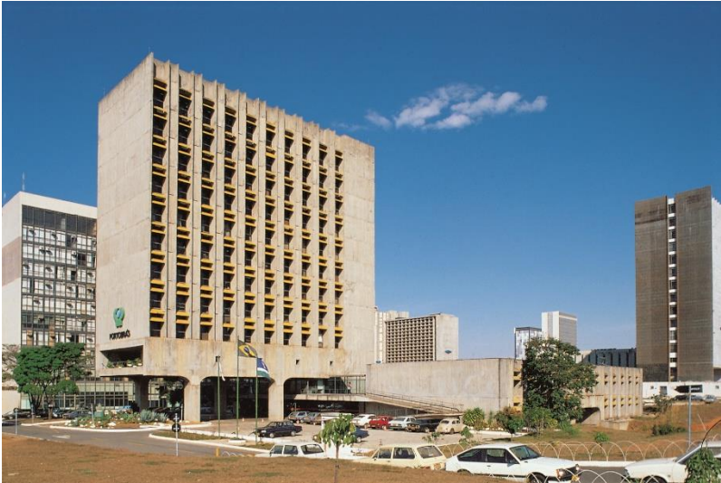
Portobras Building, Brasilia 1974
