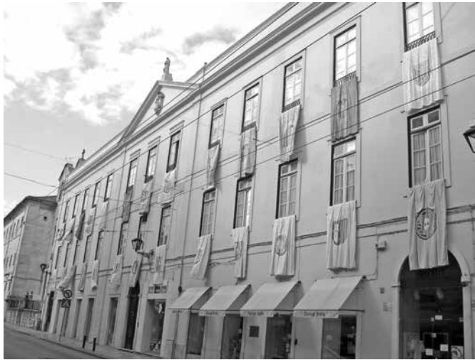
Figura 1 – Fachada principal do edifício do Carmo, rua da Sofia, n.º 114
