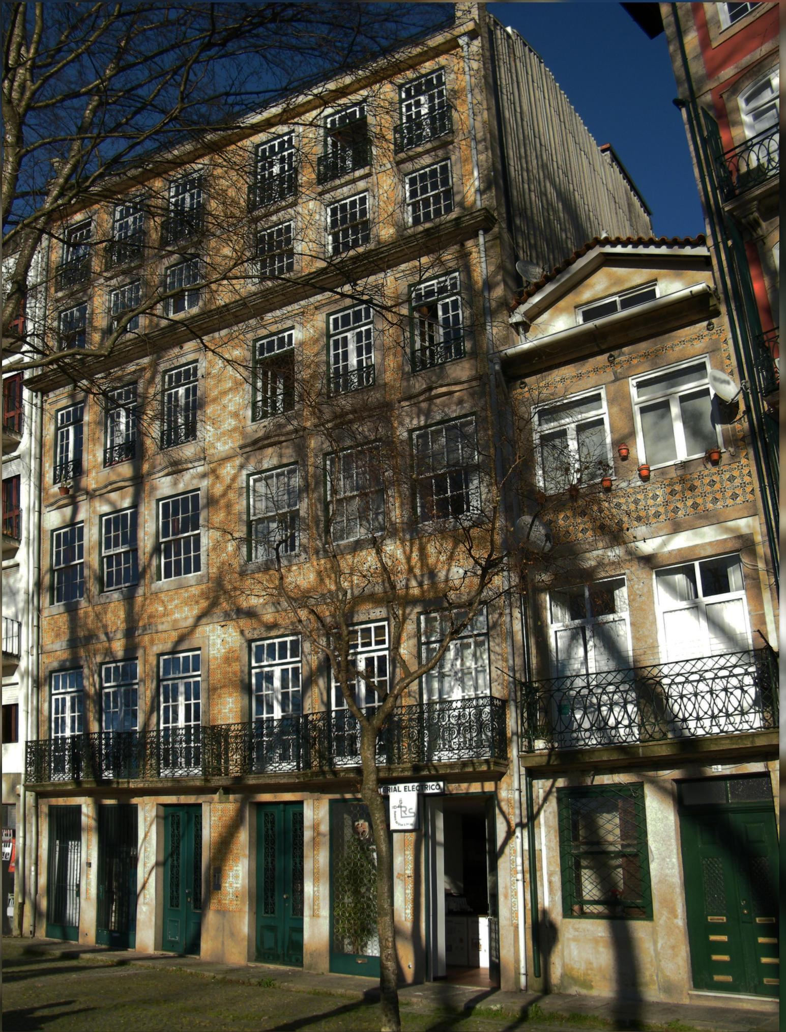
O caráter vertical dado pelos apontamentos em granito que se prolongam para além do enquadramento dos vãos de iluminação. As janelas variam entre sistemas de correr, de abas e de guilhotina e ao nível dos materiais entre madeira e inox, bem como na cor.
