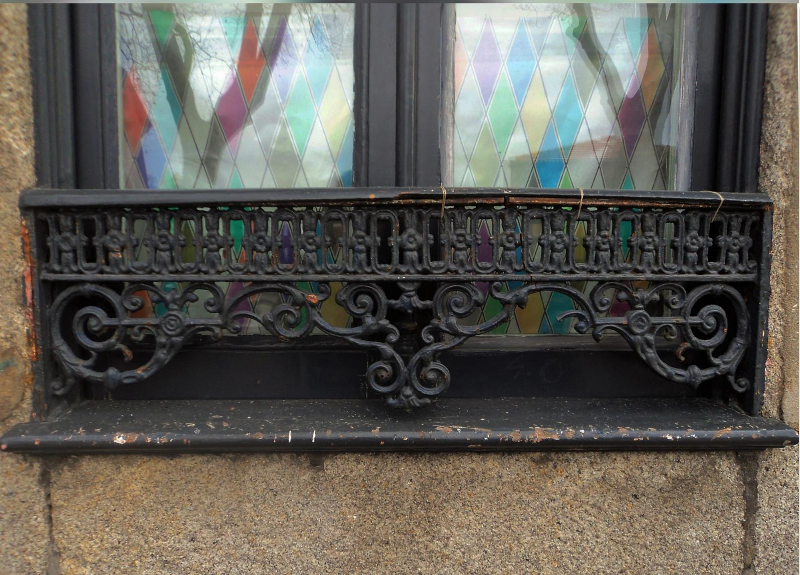
Ao longo do tempo, os materiais das edificações urbanas são substituídos por outros mais resistentes e seguros, como é o caso do tabique que, nas paredes do exterior, é substituído por alvenaria de pedra, permitindo-lhe maior resistência ao fogo. Os metais, principalmente o ferro, substituíram alguns usos da madeira, sendo aplicados nas grades de janelas de sacada, canalizações e elementos decorativos.
