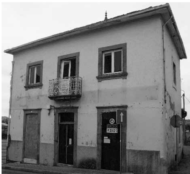
Figura 11. Imóvel onde funcionou o Colégio Lusitano de Oliveira do Douro (1907-1909).
