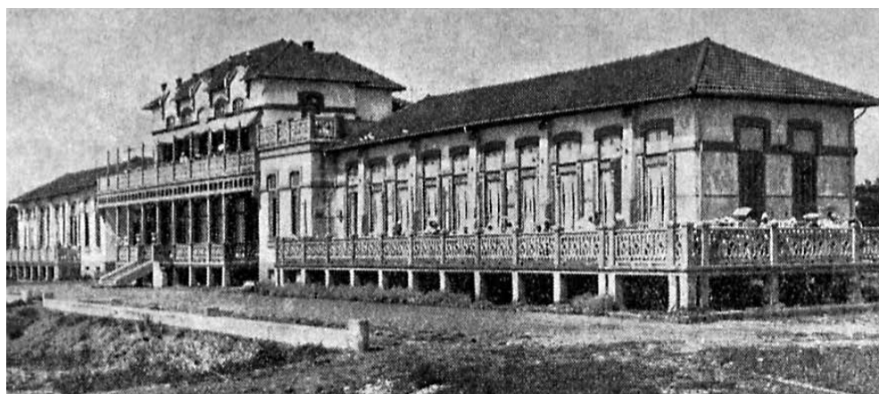
Figura 1. O Sanatório Marítimo do Norte – Valadares.
