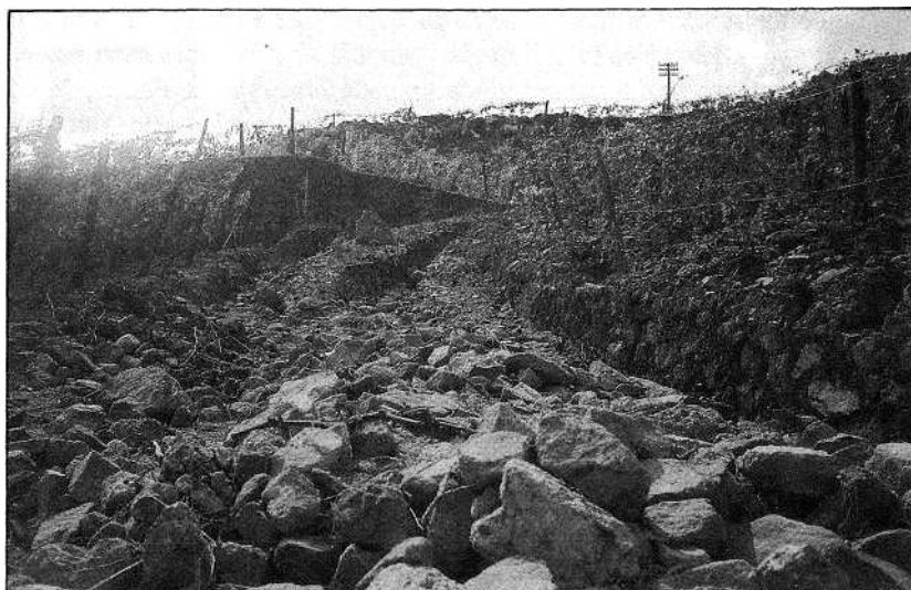
Foto 2 — Pormenor da foto anterior onde se pode observar a dimensão de alguns blocos que foram transportados (comprimento superior a 50 cm) (89/08/11).
