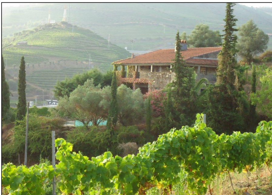
Foto 16- Antiga casa dos caseiros que, após recuperação, foi transformada para acolher turistas (Fonte: Casa e Quinta dos Varais, 2016)
