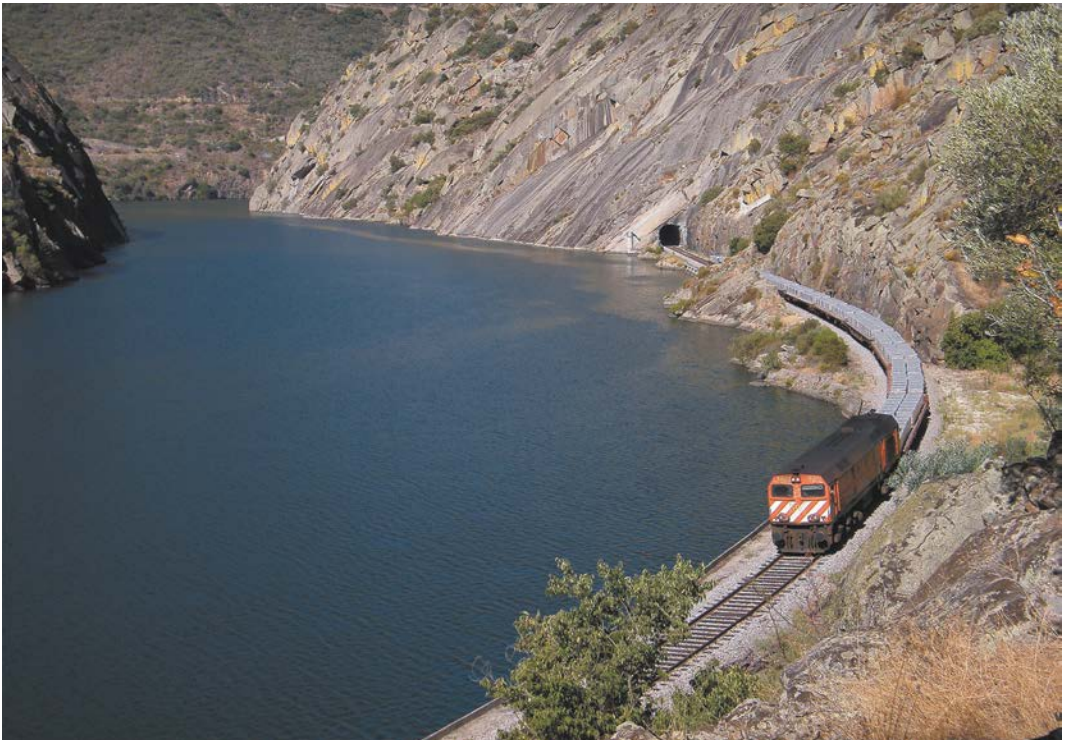
Figura 7. Douro. Túnel e linha do caminho de ferro. Obras de engenharia.
