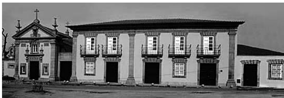
Fig. 3. Casa da Ferreira de Faldejães
