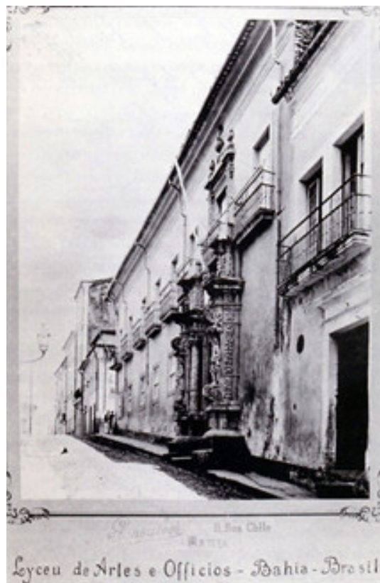
Fig. 2. Fachada Principal do Paço do Saldanha — 1906
