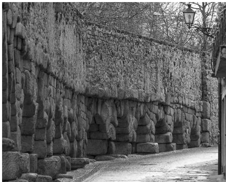
Fig. 4. Acueducto de Segovia, primeros arcos.
