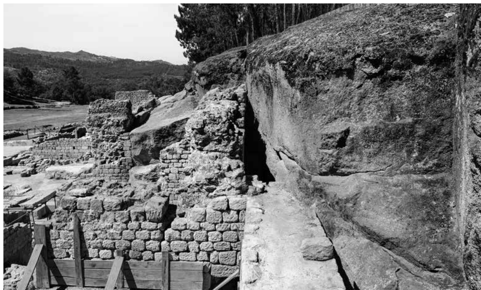
Fig. 13. Em toda a cidade é notório o trabalho de talhe dos afloramentos graníticos para servirem de alicerce dos edifícios. No caso das termas também é notória a construção contrafortada, diretamente adossada ao afloramento adequadamente talhado.
