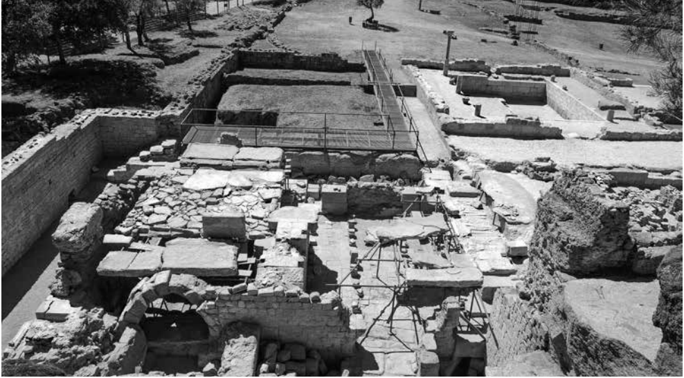
Fig. 11. O edifício das termas, cuja parte coberta ocupava um actus quadratus . Foi implantado de acordo com o plano urbano da cidade, em época de governação de Vespasiano. O projeto do edifício foi desenhado com base na proporção do passus , em todas as salas ( frigidarium , tepidarium , caldarium , apoditerium ), nos corredores e nas salas de apoio ao funcionamento.
