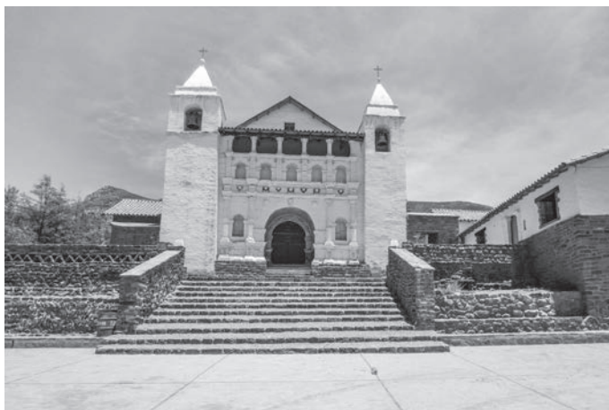
Fig. 2. Vista del Templo Santiago Apóstol de Coporaque, se observa la base y las escalinatas de piedra de origen incaico. Foto: Cristina Moreno F.
