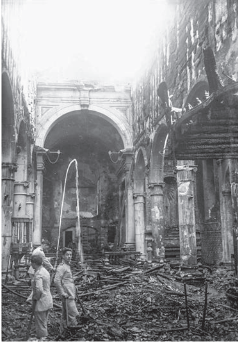
Fig. 1. Interior da igreja de S. João Baptista do Lumiar a seguir ao incêndio de 7 de Fevereiro de 1932. Arquivo Diário de Notícias.
