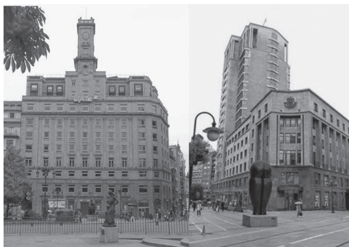
Fig. 1. A la izquierda Edificio de la Caja de Ahorros; a la derecha edificio de la Jirafa . Cedida por: Miguel Ángel Suárez, investigador del equipo de ECEPEME
