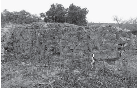
Fig. 3. Alvenarias de cortiça, Herdade da Cascada, Cortiçadas de Lavre (Montemor-o-Novo). Foto do autor.
