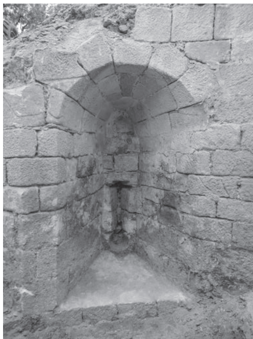
Fig. 3. Câmara de tiro da troneira 1, vista do interior do torreão.
