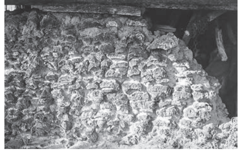
Fig. 4. Alvenarias de cortiça, Gralheira, Cortiçadas de Lavre (Montemor-o-Novo). Foto do autor.
