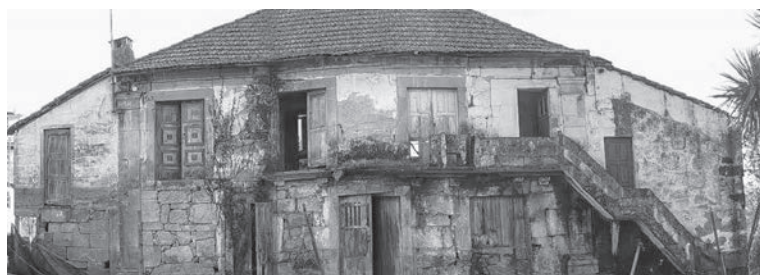
Fig. 2. Uma das casas da família Garcez em Santiago, em avanzado estado de degradação.
