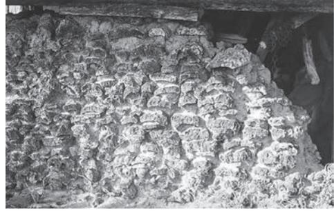
Fig. 4. Alvenarias de cortiça, Gralheira, Cortiçadas de Lavre (Montemor-o-Novo).
