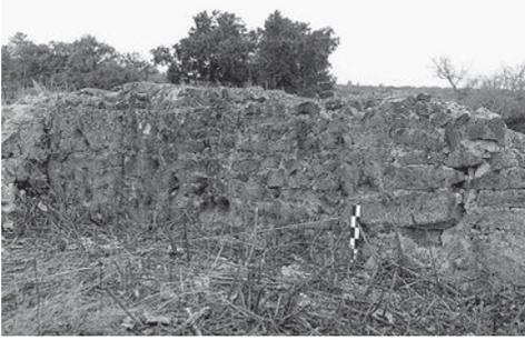
Fig. 3. Alvenarias de cortiça, Herdade da Cascada, Cortiçadas de Lavre (Montemor-o-Novo).
