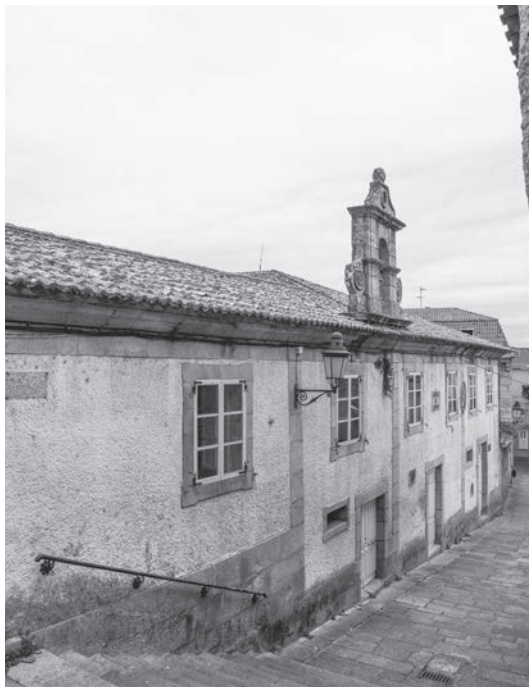
Fig. 3. Calle de la Iglesia. Foto de autor
