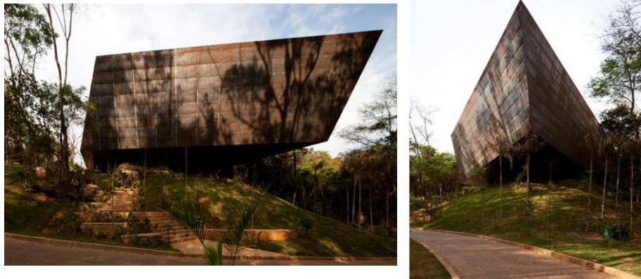
Figuras I.4.2: Pavilhão Miguel Rio Branco no Instituto Inhotim, Brumadinho – MG: Perspectiva lateral e frontal, respectivamente
