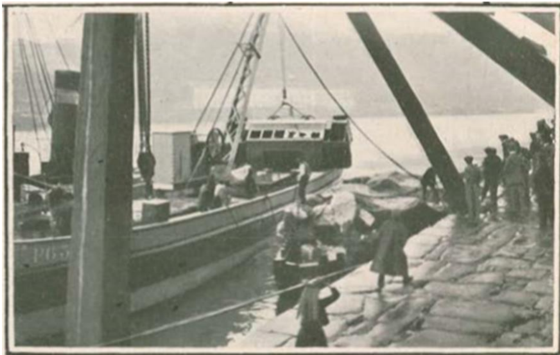
Figura 3. O atrelado n.º 33, sendo pousado no convés da “Tâmega”, após a sua remoção do rio.
