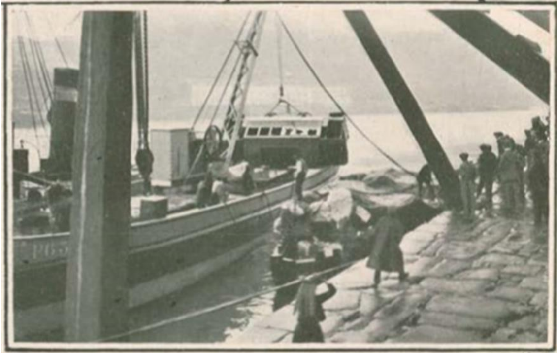
Figura 3. O atrelado n.º 33, sendo pousado no convés da “Tâmega”, após a sua remoção do rio.
