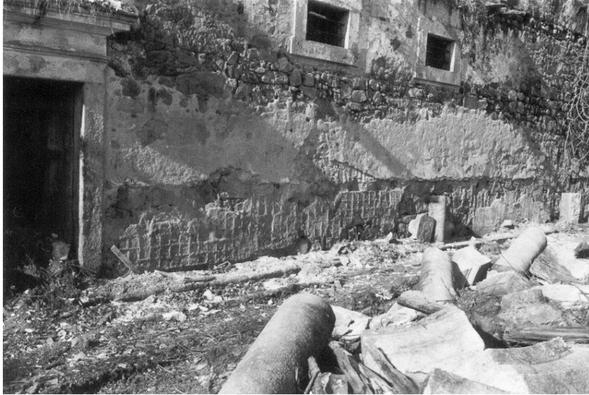
Figura 4 – Desmantelamento do claustro do refeitório do Mosteiro de São Martinho de Tibães. (1983, Arquivo do MSMT©, fotografia de Maria João Vasconcelos)
