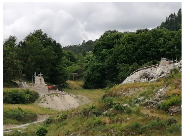
Fig. 5 – Ponte de Arame sobre o Rio Tâmega, ex-líbris turístico do concelho de Ribeira de Pena, alvo de realocação no âmbito dos trabalhos do SET. ©Emanuel Guimarães.
