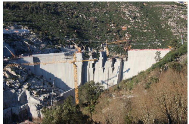
Fig. 4 – A Barragem de Daivões, cujos trabalhos se encontram em fase de conclusão. ©Emanuel Guimarães.
