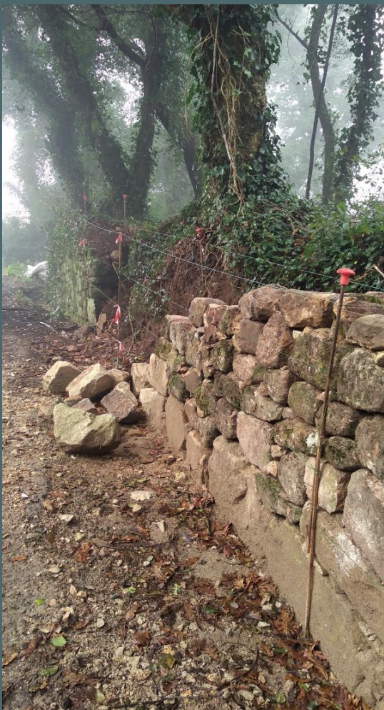
Reconstituição de muro de delimitação de caminho de acesso ao Castro com utilização de blocos pétreos semelhantes aos utilizados na região. Fotografia de DF.
