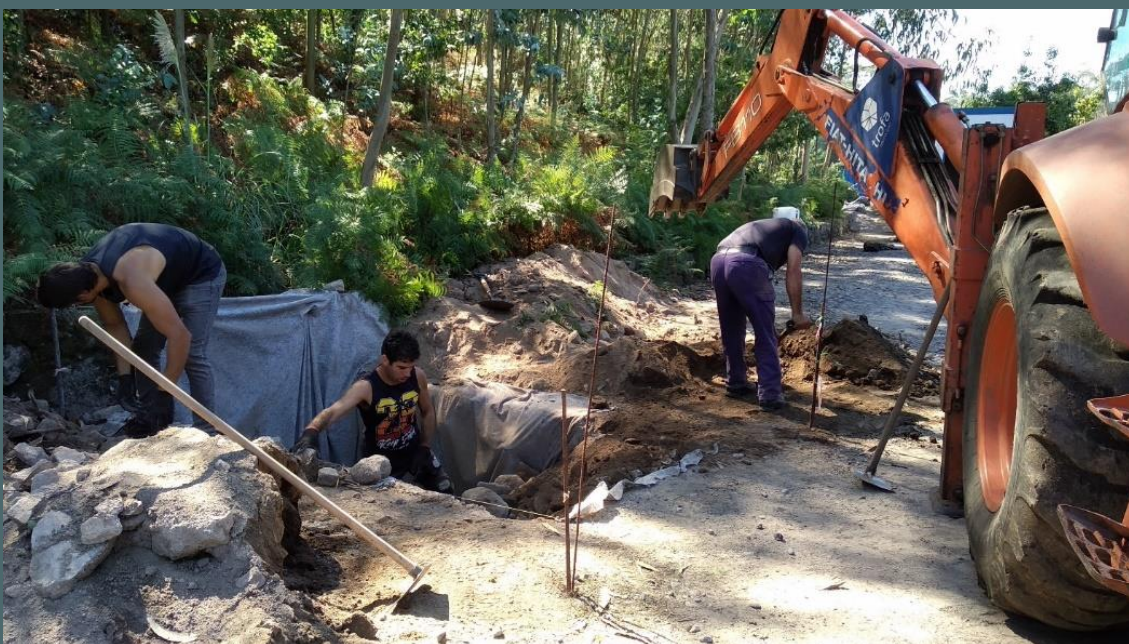
Fecho das sondagens 4 e 6, para proceder à posterior recuperação do piso, assente na cobertura das sondagens após limpeza, consolidação e selagem das estruturas intervencionadas. Fotografia de VB
