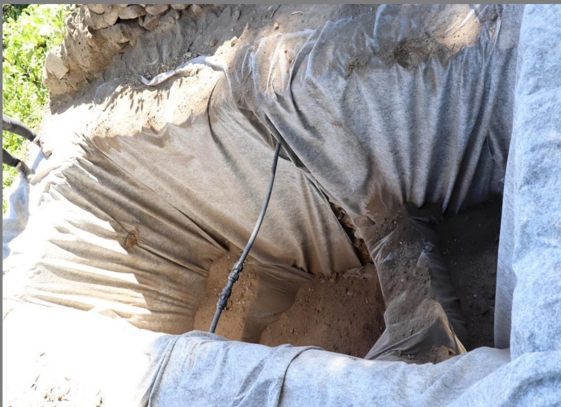
Vista geral da área intervencionada (sond. 06) durante o processo de aterro. Fotografia de DF.
