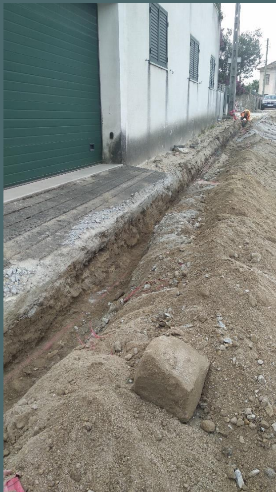
Trabalhos iniciais (abertura de valas) para instalação e requalificação da rede pública de iluminação na zona de acesso ao Castro de Alvarelhos. Fotografia de DF
