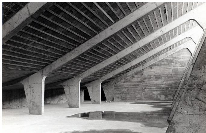
**Fig. 28.** Centro de Convivência Cultural de Campinas, vista interior com colunas e vigas de sustentação da bancada, 1973
