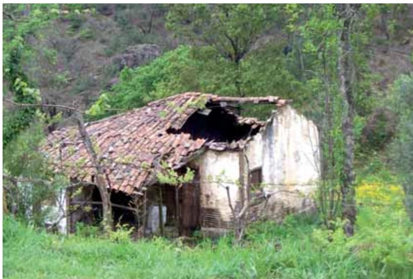
Figura 1.1- Cabeceiras de Basto. Casa de lavoura com a parede frontal em pedra, e parede exterior traseira em tabique fino, rebocado apenas com argamassa, e sem qualquer resguardo adicional.
